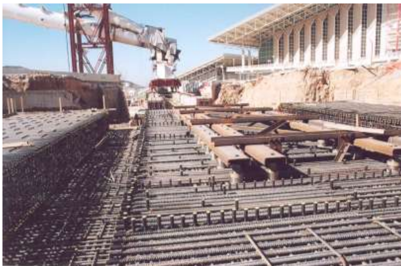
ΒΔ θεμέλιο πριν την πρώτη φάση σκυροδέτησης
