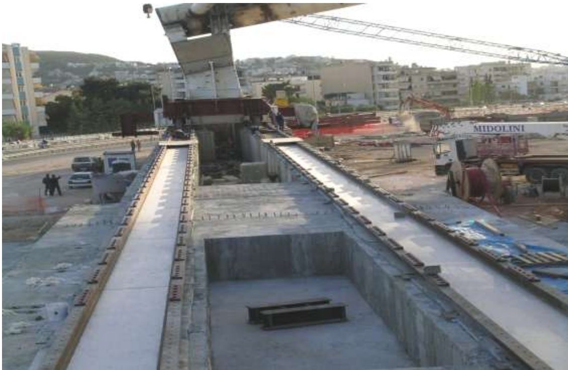
Φορέας ολίσθησης ΝΔ θεμελίου μεταλλικής κατασκευής κάλυψης Σταδίου ΟΑΚΑ
