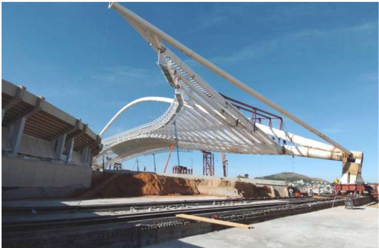
Γενική άποψη Δυτικού τόξου μεταλλικής κατασκευής κάλυψης Ολυμπιακού Σταδίου και φορέας ολίσθησης ΒΔ έδρασης
