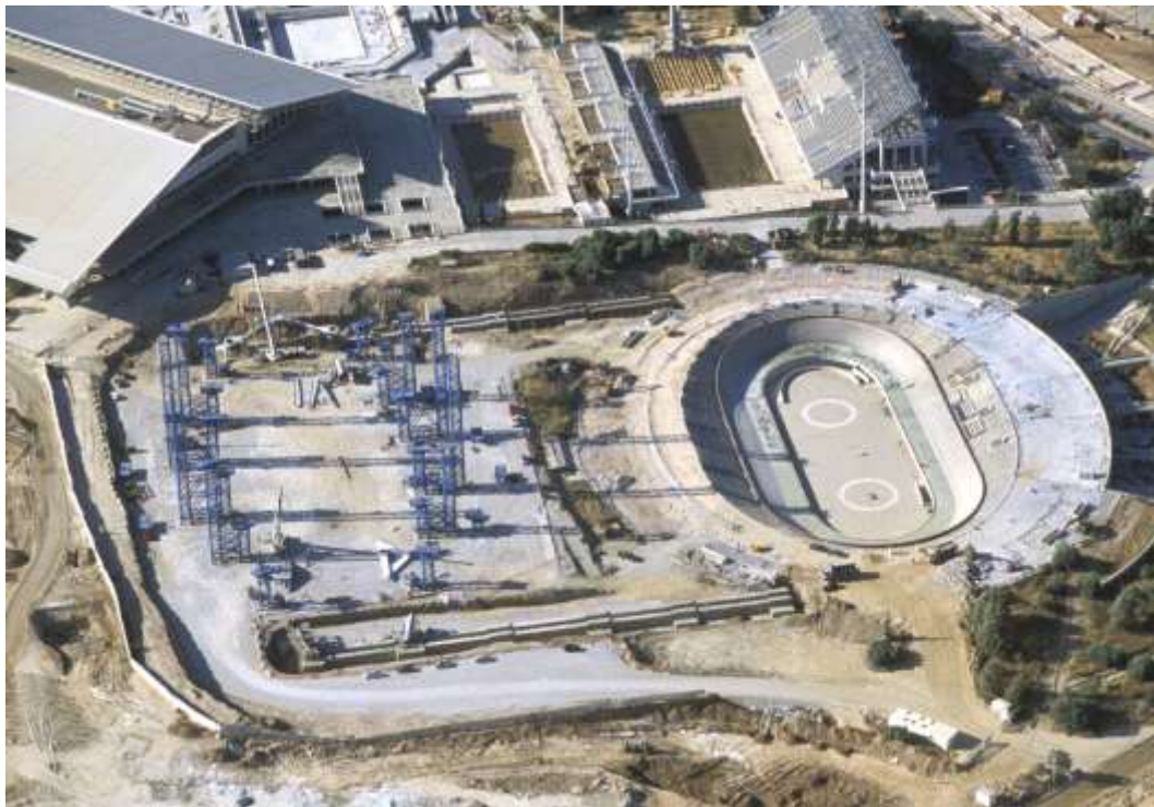
Ποδηλατοδρόμιο: Αριστερά διακρίνεται η θέση συναρμολόγησης της οροφής με τους βοηθητικούς πυλώνες και οι φορείς ολίσθησης
